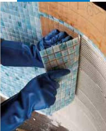
Укладка стеклянной мозаики 2х2 в бассейне с использованием Adesilex P10 и добавки Isolastic, разбавленной водой в соотношении 1:1
